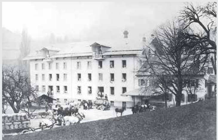
Oben: Die Bäckerei (vor 1889), wo mit der Knetmaschine (rechts) und der Walze (links) die gelochten Brotfladen aus Weizenmehl hergestellt wurden. Unten: Das Mehl lieferten die Mühlen in «Gilamont», Vevey, von Pierre-Samuel Roussy, der 1875 zu den Käufern der Firma Nestlé gehörte (1882). Rechts: Die Öfen in der Bäckerei (vor 1889). Die gebackenen Brottafeln wurden anschliessend fein gemahlen, mit kondensierter Milch vermischt und getrocknet.
